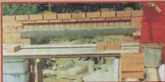
26. Над декоративным карнизом проложен выравнивающий кладку ряд из «тонких» кирпичей. Выше – уже обычный ряд лицевой кладки стены.
