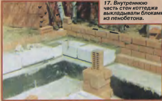
18. Для лучшего скрепления кирпичей наружной и внутренней кладки стены прокладывали через каждые два ряда блоков стальную сетку.
