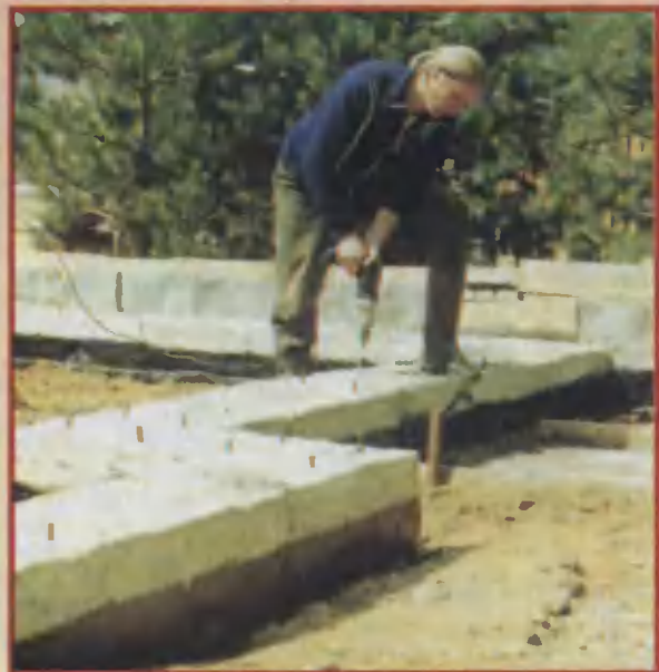
3. В верхнюю плоскость ленты загнали штыри из арматуры. К ним затем будет прикручен каркас из арматуры Ø16 мм и дорожная сетка.
