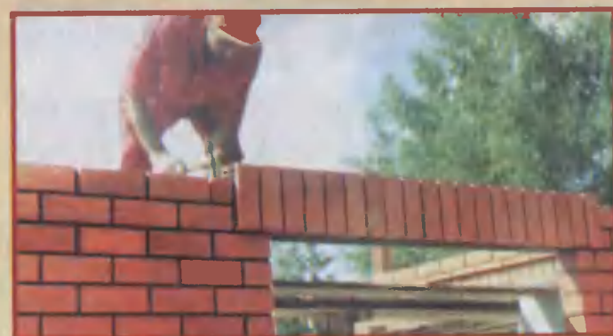
24. Каменщик ставит на место небольшой «подставок», выравнивая его положение в ряду кирочкой.
