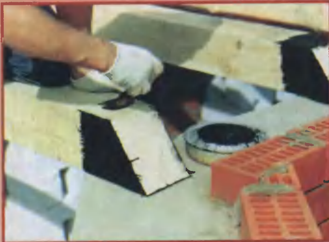
33. Концы балок промазали битумной мастикой, оставляя скошенную часть без обмазки.
