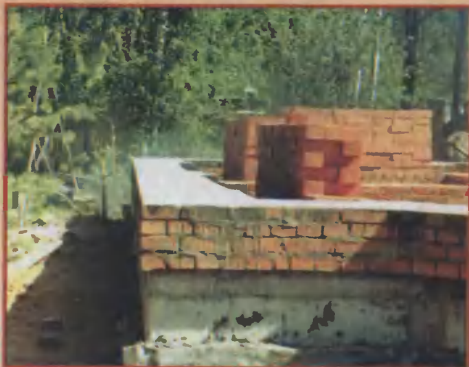
11. Сверху выложенного цоколя устраивают выравнивающую цементную стяжку.
