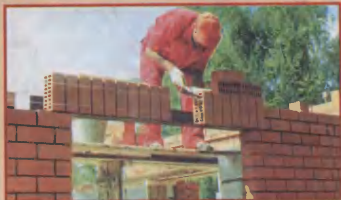
23. Кладка карниза. Нижняя бечевка позволяет контролировать выпуск кирпичей наружу.
