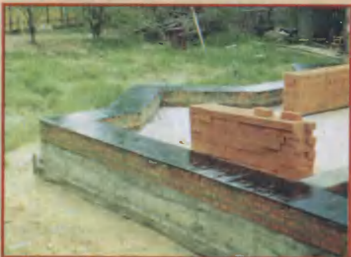
12. По поверхности цоколя на цементную стяжку мы нанесли слой битумной мастики.
