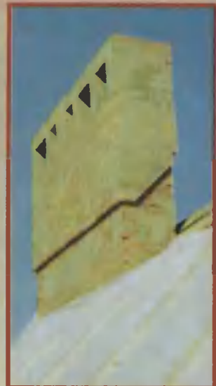
49. Печная труба с проходящими в ней вентиляционными каналами закончена. Благодаря «выдре» обеспечивается надежная защита от воды стыка трубы с крышей.
