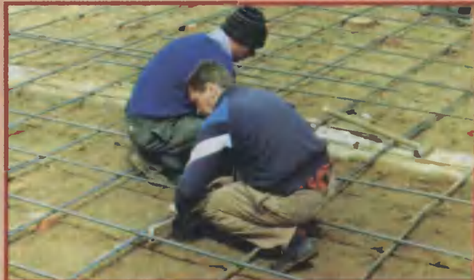
5. Арматура А-III Ø16 мм равномерно уложена и приподнята над песком на толщину кирпича (65 мм), а все узлы провязаны проволокой.
