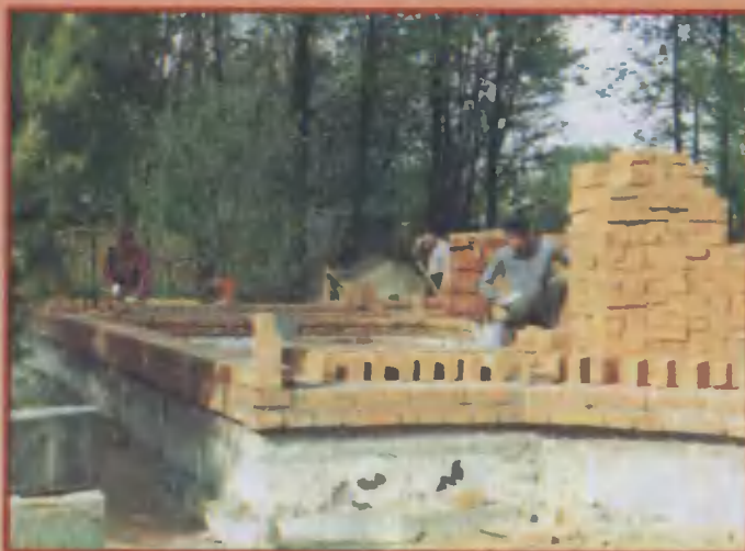
10. Неточности изготовления плиты каменщики компенсируют на этапе изготовления цоколя.
