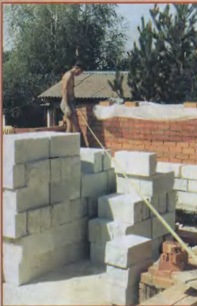
19. Периодически измеряли диагонали коробки дома двадцатиметровой рулеткой.
