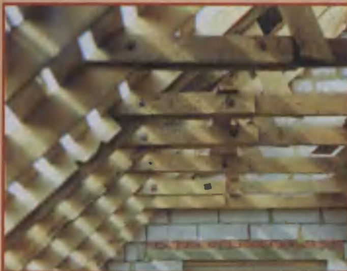
44. После того как установили ригели, всю систему дополнительно надежно скрепили.
