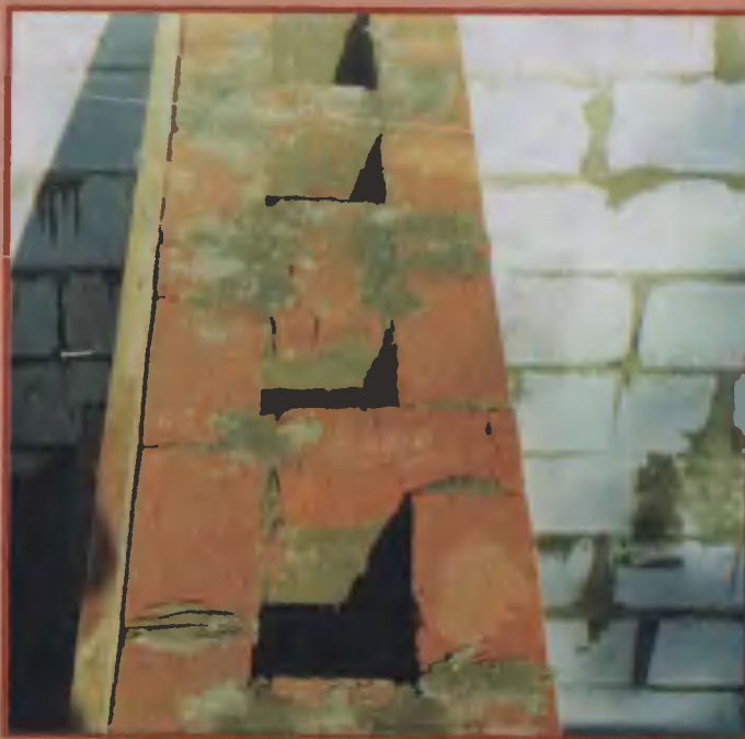
31. Часть несущей стены, в которой проходят вентиляционные и дымовые каналы. Под бечевками на стене укреплена выравнивающая доска.
