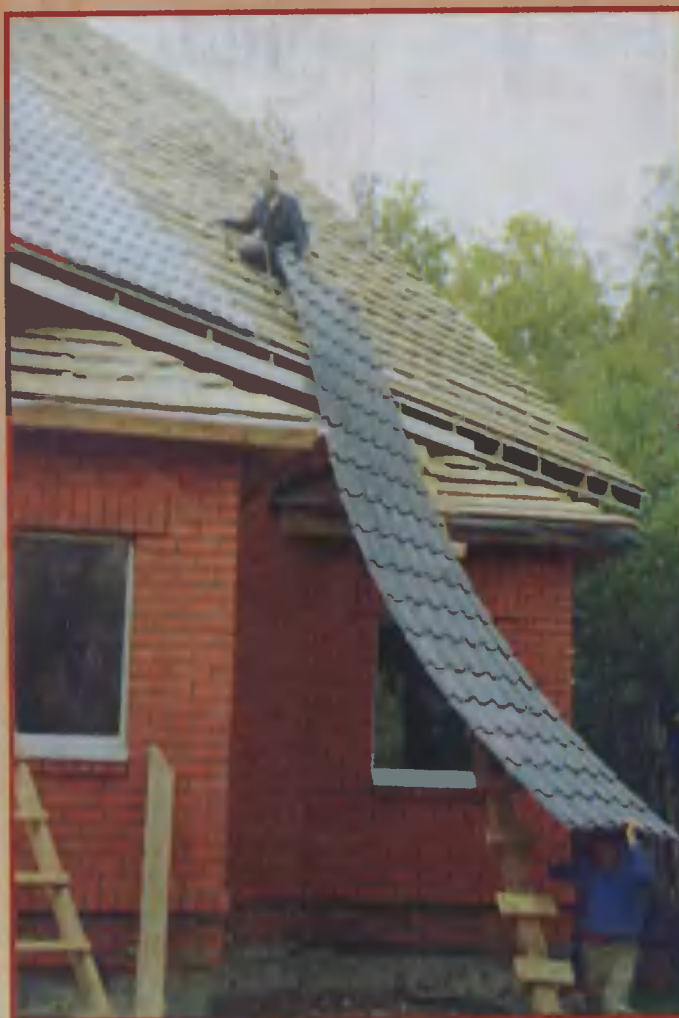
52. На скат кровли монтажники втягивают очередной лист металлочерепицы.
