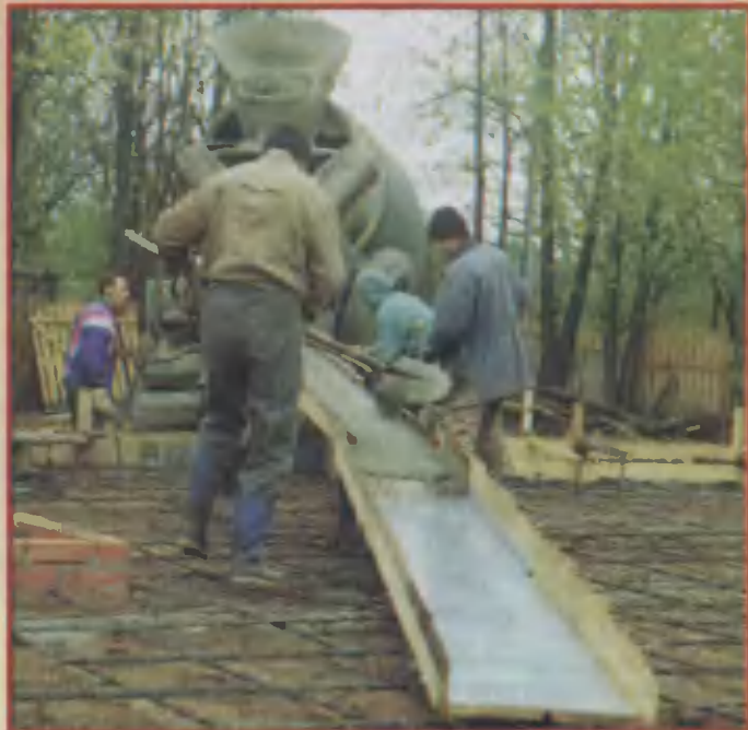
6. В готовую опалубку пошел бетон. Заливка фундамента началась.
