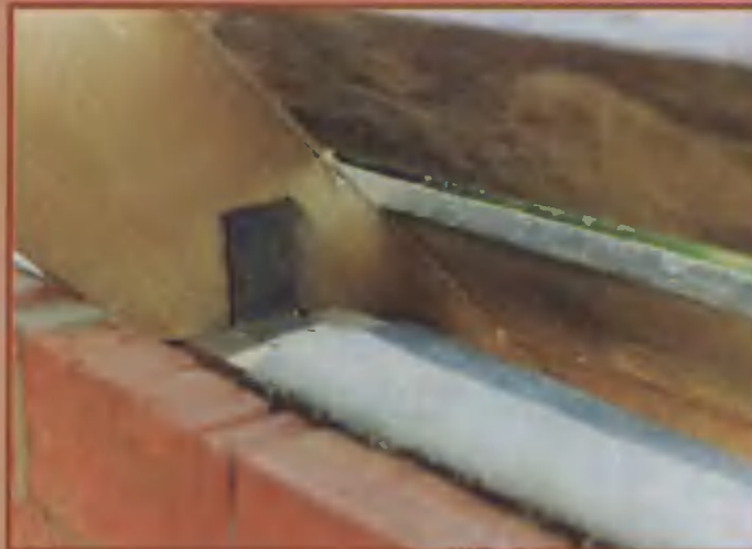
43. Стропильные ноги с мауэрлатами скрепили металлическими уголками.
