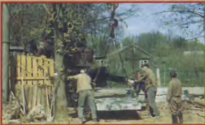
2. Разобрав часть забора, мы уложили дорожные плиты на заранее спланированную часть участка.
