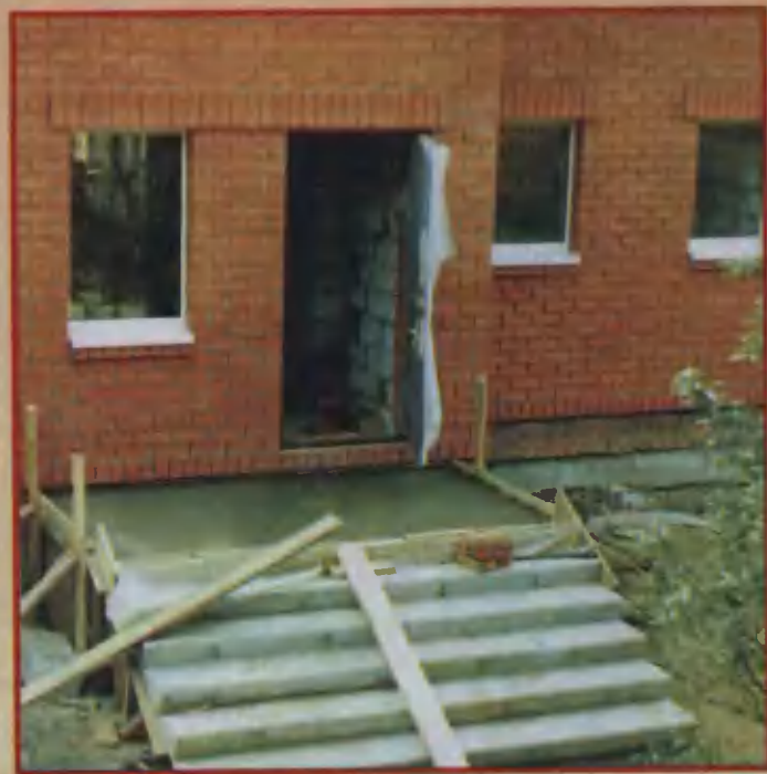
53. После заливки поверхности коробки лестничной площадки бетоном центральный вход приобрел почти заверченный вид.
