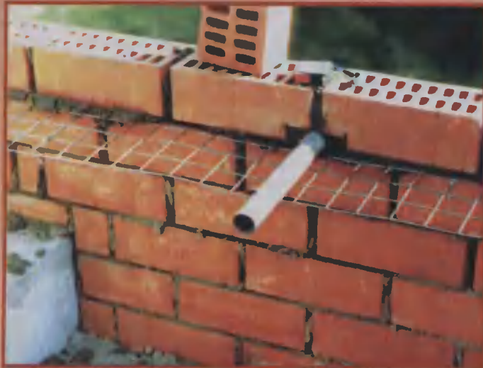
28. «Ввод» в лицевой кладке стены. Трубу (3/4") заложили в процессе кладки в стену. В ней пройдет электрокабель. Для этого пришлось выбрать «болгаркой» часть углов кирпичей.
