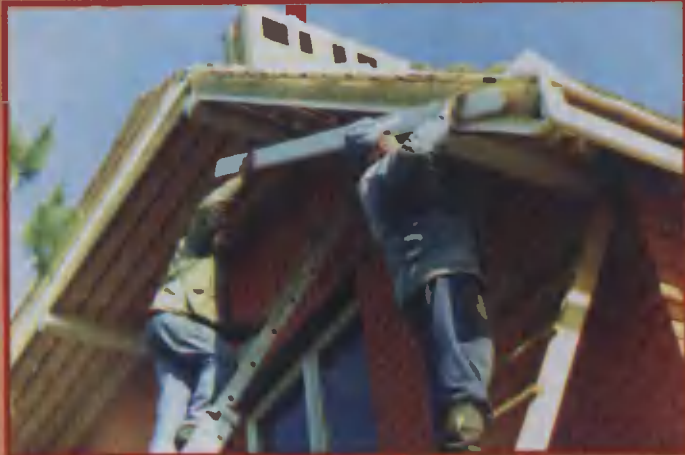
51. Аккуратно и не спеша монтажники устанавливают ПВХ-вагонку.
