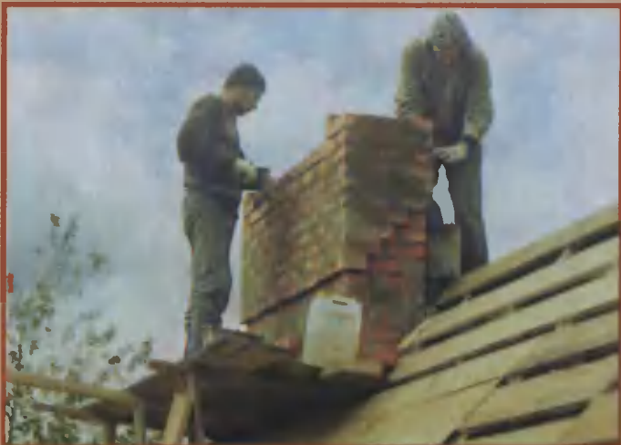
47. Для кладки оголовка трубы сделали на скате крыши небольшую площадку.
