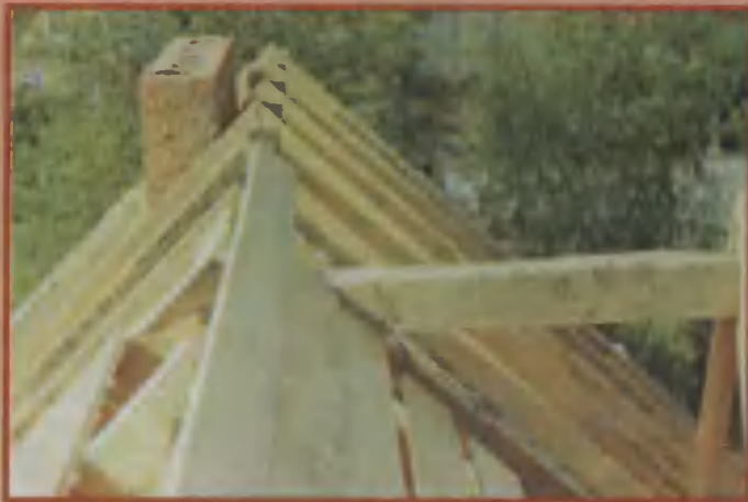
46. На точно установленные стропила легко прибивать обрешетку, доски которой образуют ровную поверхность.
