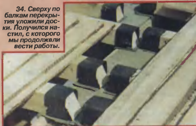
33. Концы балок промазали битумной мастикой, оставляя скошенную часть без обмазки.
