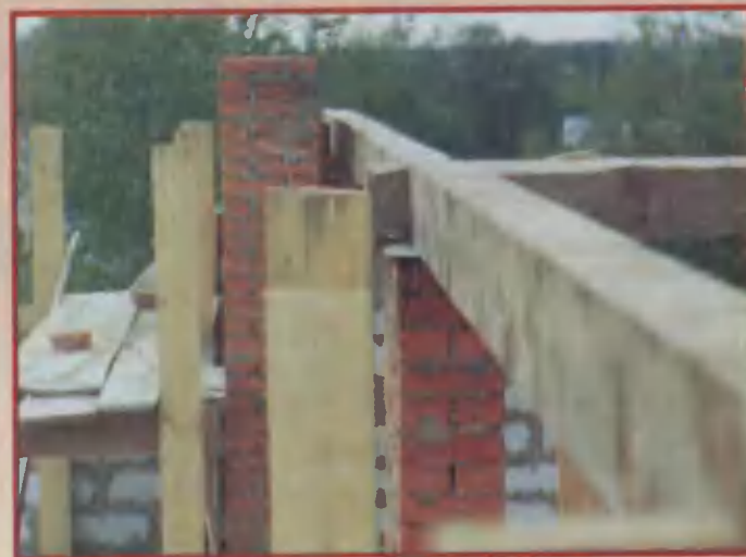
39. Выложив до нужной высоты трубу и опорный столб, мы краном уложили на столб и фронтоны коньковые брусья.
