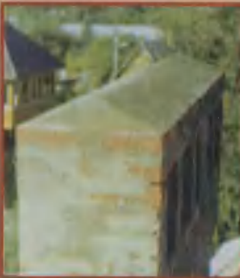
48. Чтобы вода не попадала внутрь каналов, сверху трубы сделали защитную «шапку».
