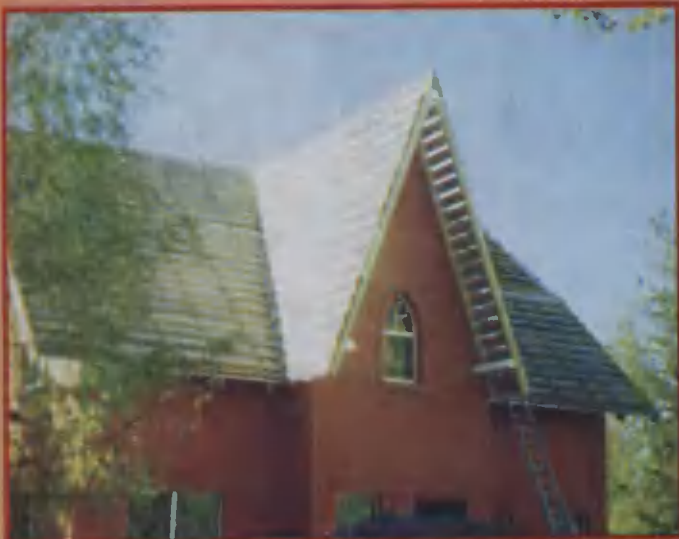
50. На крышу положили паропроницаемую пленку и закрепили ее. Дождь коттеджу уже не страшен. Крышу можно покрыть кровельным материалом.
