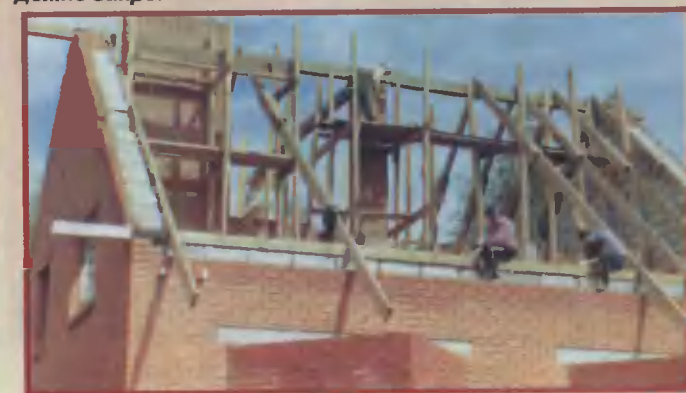
42. На крыше работа идет медленнее, но стропильная система должна быть точно установлена и надежно закреплена.
