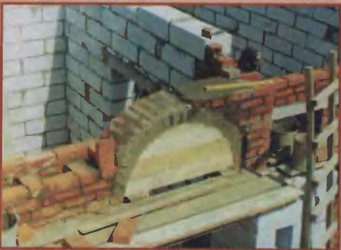
29. Внутренние стены выложили из пенобетона. Проем из кухни в зал сделали в виде полукруглой арки.
