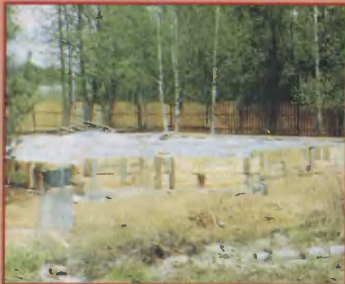
7. Всю поверхность монолитной плиты мы закрыли сверху полиэтиленовой пленкой.
