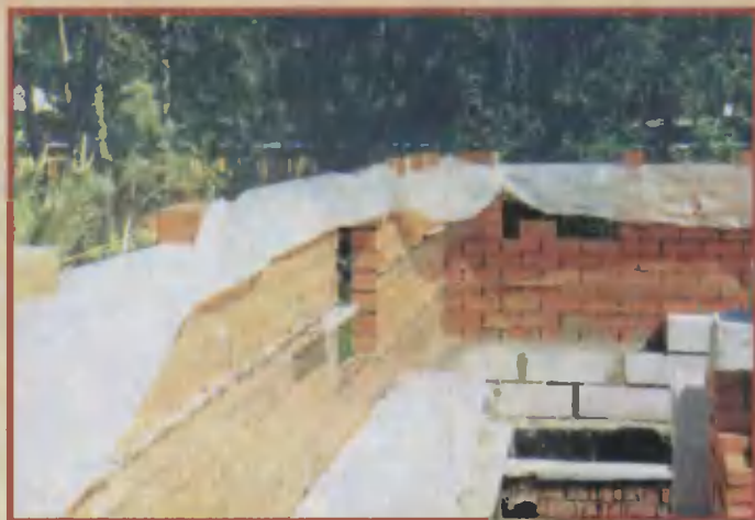
21. Если начинался дождь, то лицевую кладку обязательно укрывали сверху пленкой.
