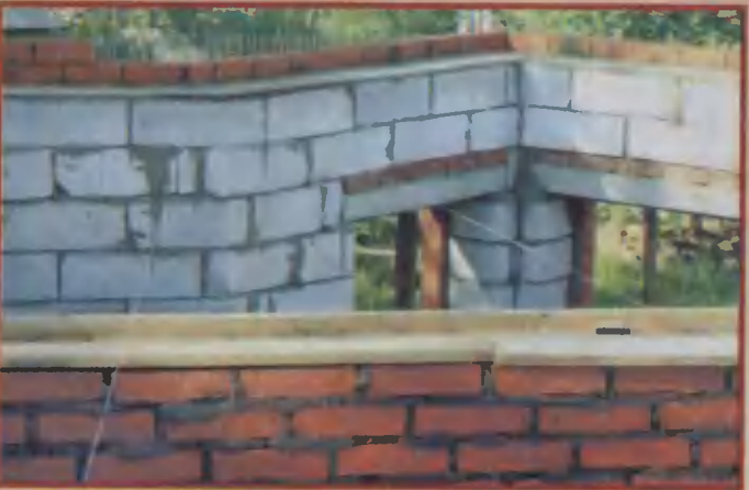
30. Протянув от одной стены до другой бечевки, определили, какой будет толщина стяжки на несущей стене.
