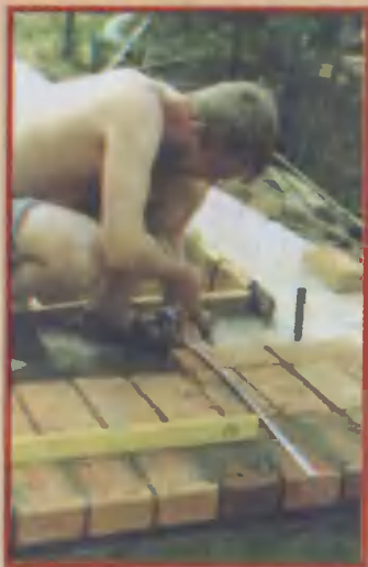
9. Начало кладки цоколя. Чтобы сделать его в точном соответствии с проектом, необходимо тщательно выдерживать все размеры.
