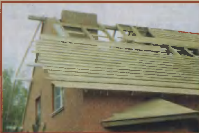
45. Края досок обрешетки выпустили за лобовые доски с небольшим запасом, чтобы затем опилить их по месту.
